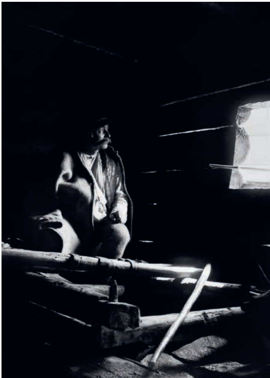
Wojciech Roj na budowie willi na Anfatówce, ok. 1903–1904
