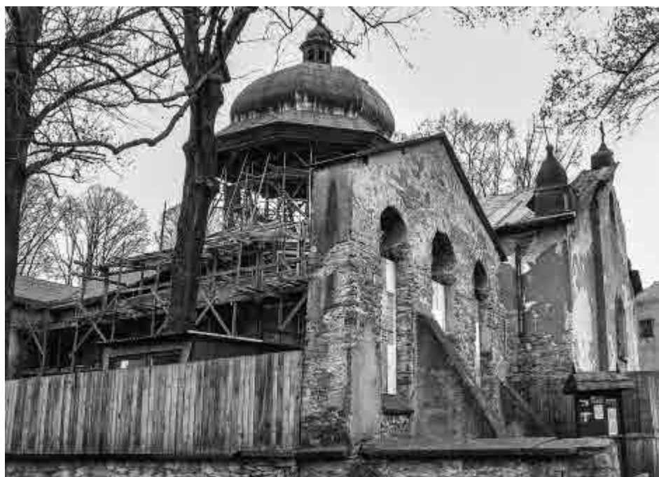
Cerkiew greckokatolicka w Baligródzie w trakcie remontu ▪ fot. Krzysztof Potaczała
