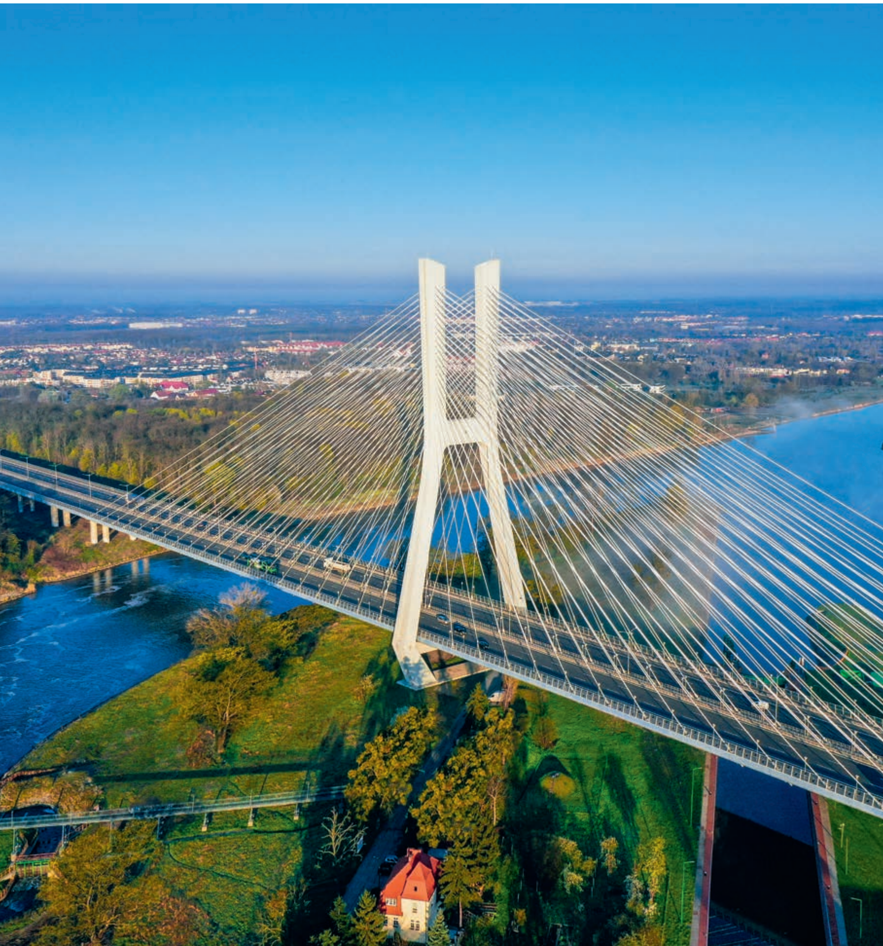
Rędziński Bridge on the Oder River in Wrocław
