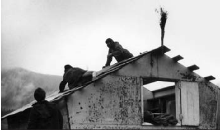
Wiecha już stoi. Ekipa przybija deski na dachu
